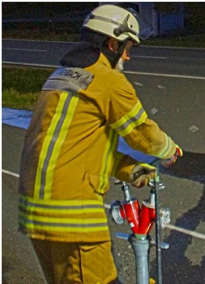
*Inbetriebnahme eines Unterflurhydranten*
